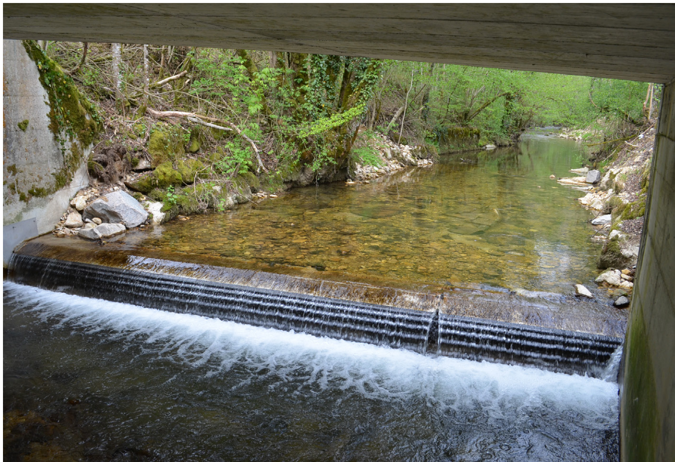
Abb. 2: Krebsperre in der Lützel im Kanton Baselland: Die Brückenpfeiler dienen als seitliche Rückführung bzw. Landgangssperre.
