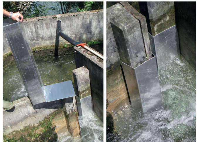
Abb. 1: Beispiel einer Krebssperre für einen Becken-Schlitz-Pass aus Münchenstein (BL). Nach neuem Kenntnisstand müssen zusätzlich weitere Bleche an den Wänden des Beckens und der 90° Winkel abgerundet werden.
