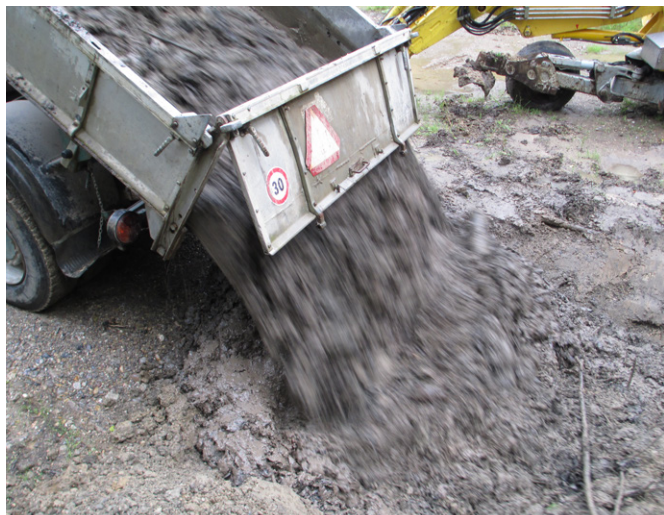
Divers travaux effectués sur des points d'eau constituent un risque de déplacement d'écrevisses invasives infectées par la peste de l'écrevisse.
