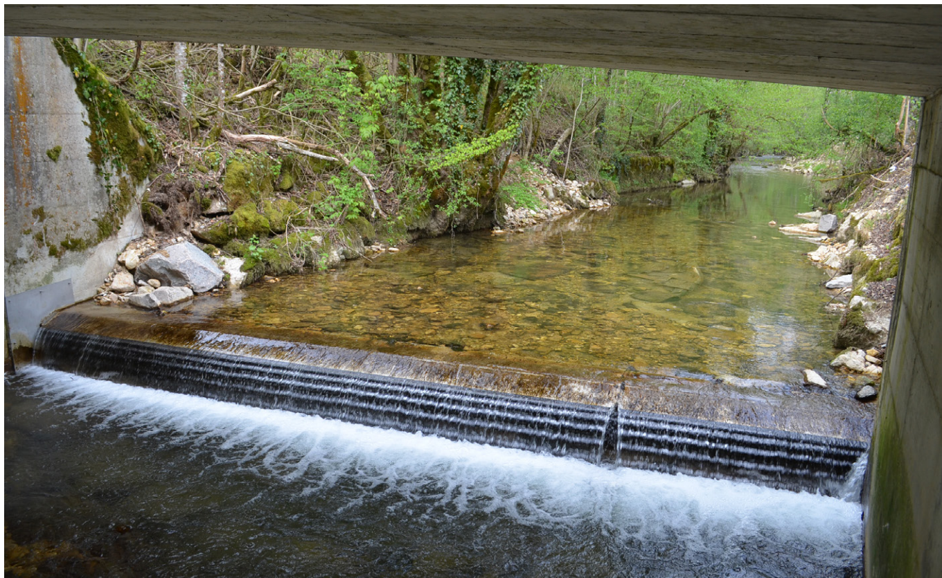
Illu. 2 : Barrage à écrevisse dans «la Lucelle» dans le canton de Bâle-Campagne: les obstructions latérales du pont servent à diriger les écrevisses vers le bas et les empêchent de contourner le barrage par les côtés.
